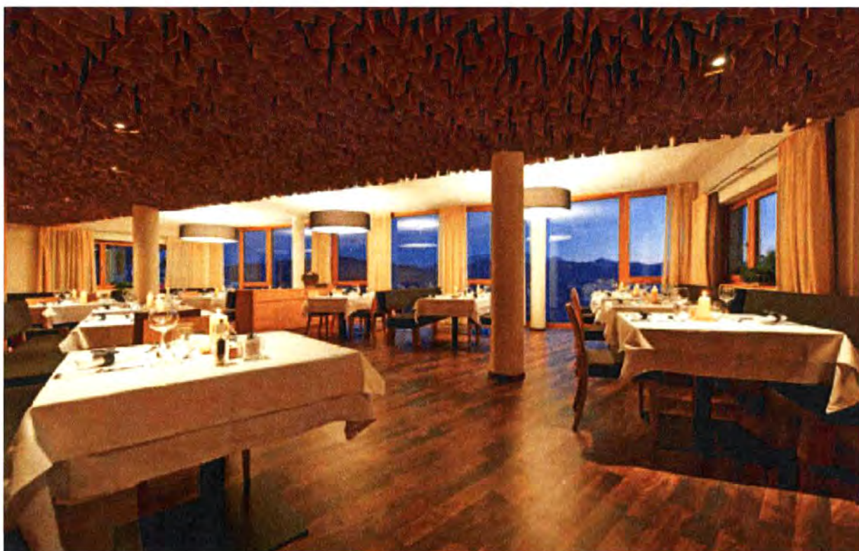
Il soffitto del ristorante è stato realizzato con 12.000 tavolette di legno agganciate a una rete elettrosaldata. Oltre all'impatto estetico originale, abbattere in maniera assai efficace il rumore
